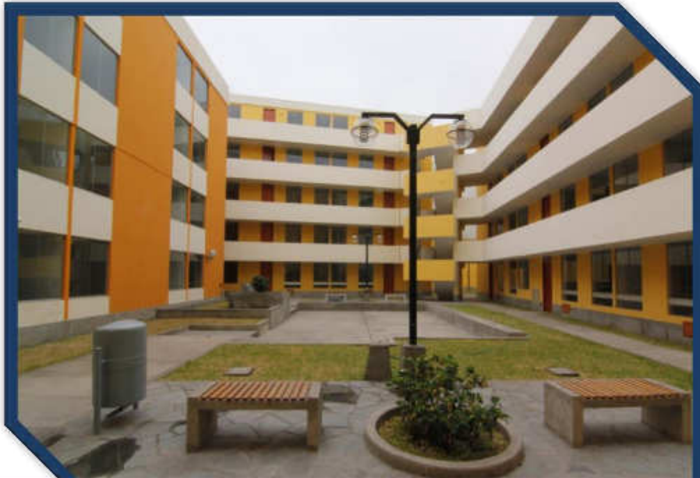
VISTA PANORAMICA DE LA FACHADA DE LOS BLOQUES "D - E - F" DEL CONJUNTO HABITACIONAL MONSERRATE
